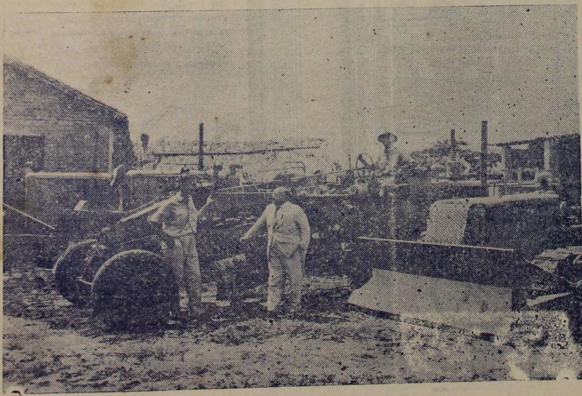
Vista parcial da garage e oficinas do competente construtor, vendo-se possante e moderníssima maquinária no páleo da garage, cuja dimensão é de 3.200 metros quadrados, numa área coberta de 740 metros quadrados.
